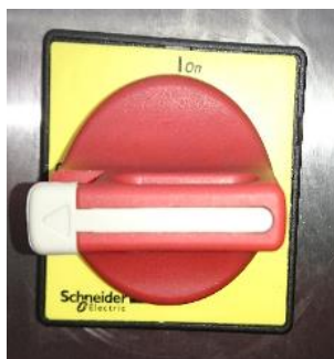
Rys. 1 Rozłącznik główny
